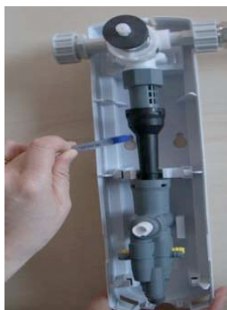
3. Använd baksidan av höljet som mall för att markera var de (3) skruvhålen för rawlpluggen ska sitta.
